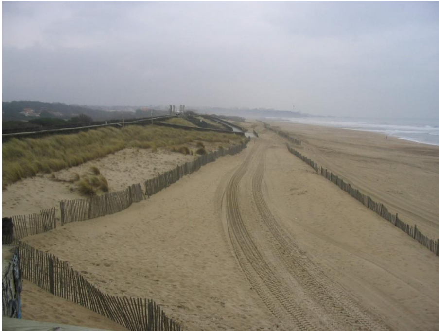
Illustration 225 - Plage sableuse d'Anglet (©OCA, 2008). Aménagement piétonnier du cordon dunaire. La gestion hivernale de la plage s'effectue par l'installation de ganivelles pour stocker le sable au niveau de l'interface dune/plage sur le cordon dunaire résiduel
