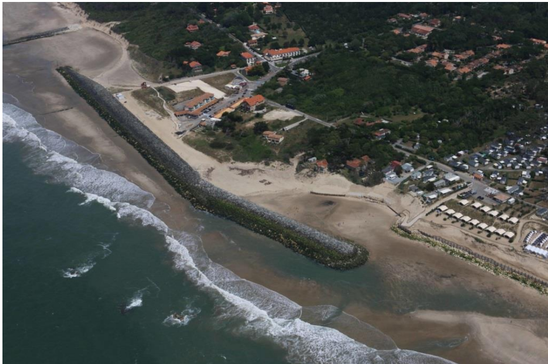
Illustration 123 - Vue aérienne de L'Amélie en 2016 et des ouvrages de protection côtiers mis en œuvre. L'érosion est forte de part et d'autre de l'enrochement central, en atteste la position des blockhaus submergés en bas à gauche de la photographie (©OCA, 07/06/2016)
