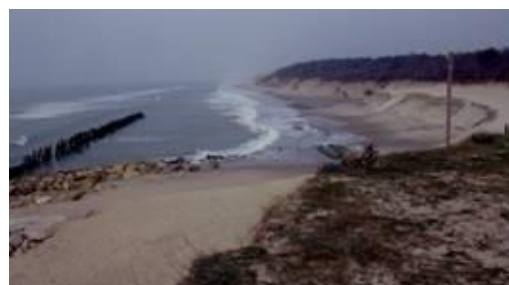
Avril 2003, l'érosion marine reprend le sable apporté dans le fond de l'encoche et découvre les géotextiles posés
