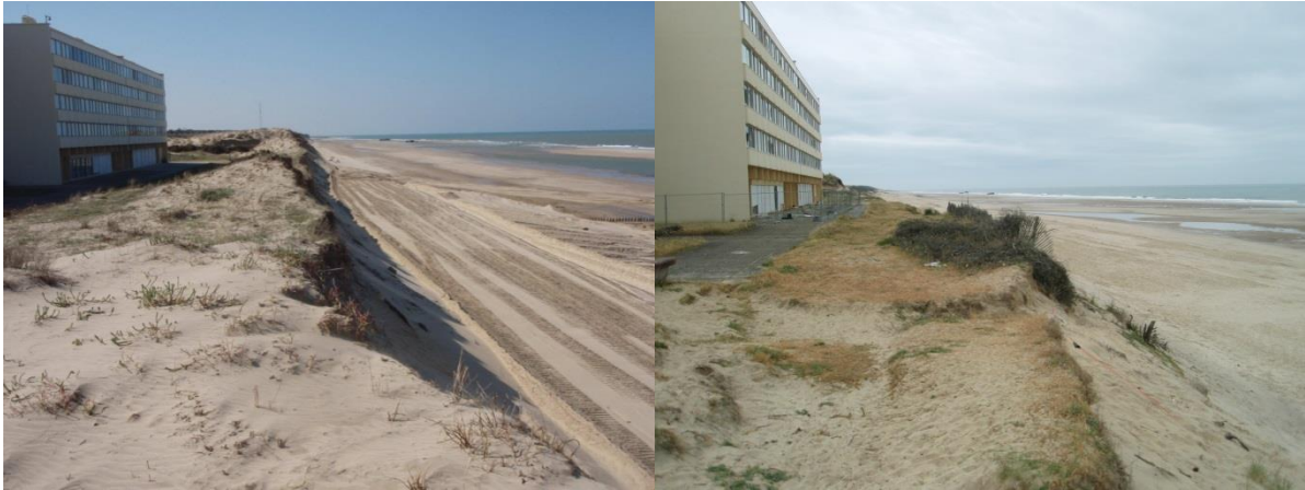
Illustration 116 - Contact dune/plage au sud de la sous-cellule 1.4. Falaise d'érosion marine au sud de Soulac-sur-Mer, au droit de l'immeuble « le Signal » (OCA, 12/04/2010) et situation après l'épisode de tempêtes de l'hiver 2013/2014 (à droite, OCA, 01/06/2015).
