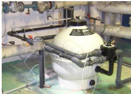
Photographie – Filtre de traitement d'un bain à remous
